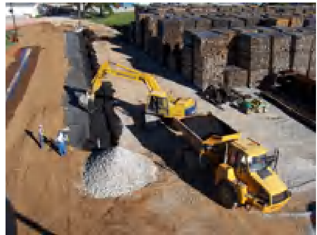
透過性浄化壁工事状況
