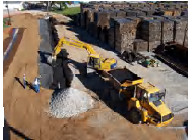
透過性浄化壁工事状況
